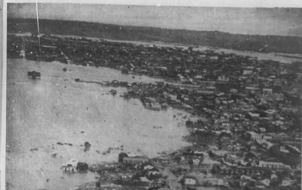
Vista aérea de la progresista ciudad mexicana. Luchamientos después del cruce del violento meteo que tantos daños produjo. En la foto pueden observarse casas con piso totalmente demanteladas.
