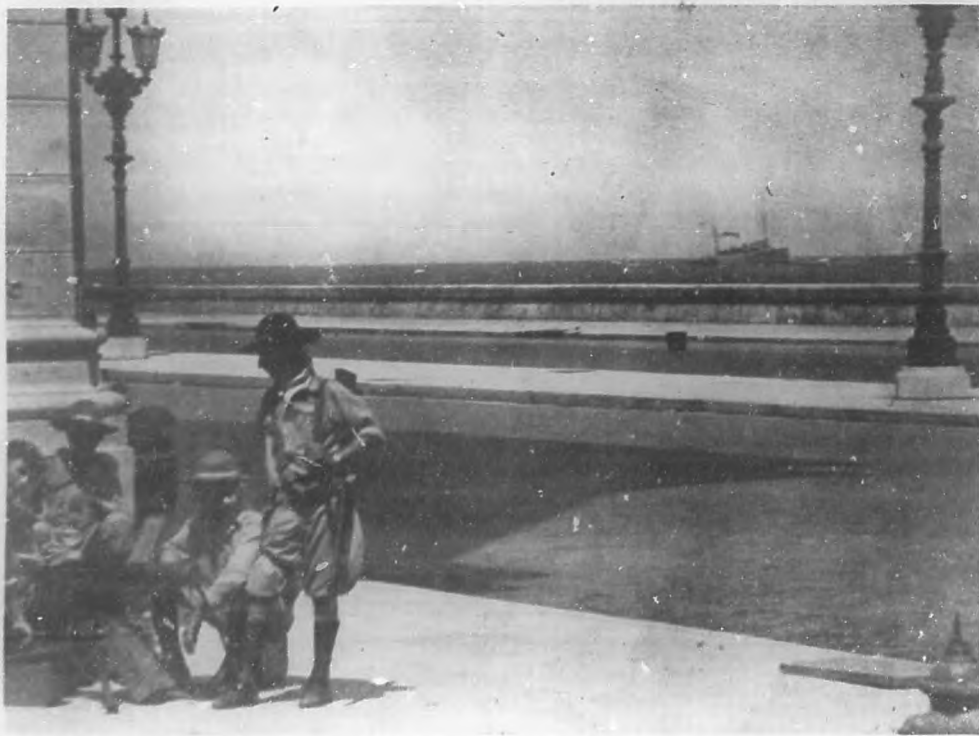
El buque-escuela "Patria", que tuvo intervención en el combate de Gibara es el mismo que se situó frente al Hotel "Nacional" para tomar parte en la contienda entre Oficiales y el Ejército, disparando sus cañones dos veces.
