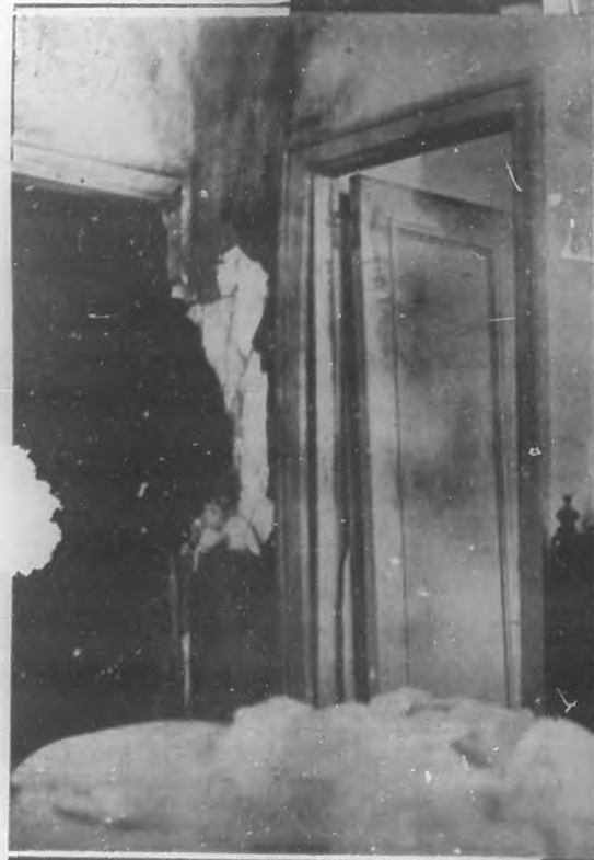
Las balas de cañón perforaban dos y tres de las paredes interiores del Hotel. Esta foto muestra el impacto de una bala de cañón, junto a la divisoria de dos lujosas habitaciones.
