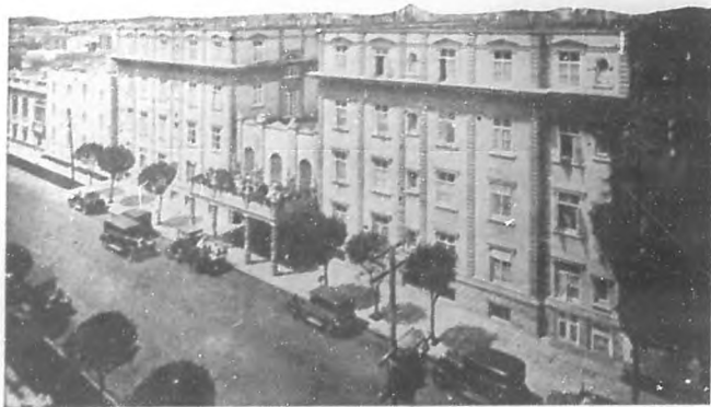
FACHADA DEL HOTEL
